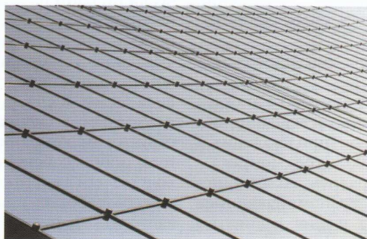
Рис. 4. 400 точечных светодиодных светильников смонтированы в узлах
