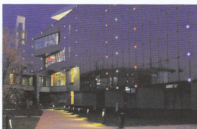
Рис. 6. Освещение стеклянного фасада и прилегающей территории ТРЦ «Маяк»
