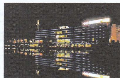
Рис. 7. Светящийся фасад ТРЦ «Маяк» — вид со стороны озера
